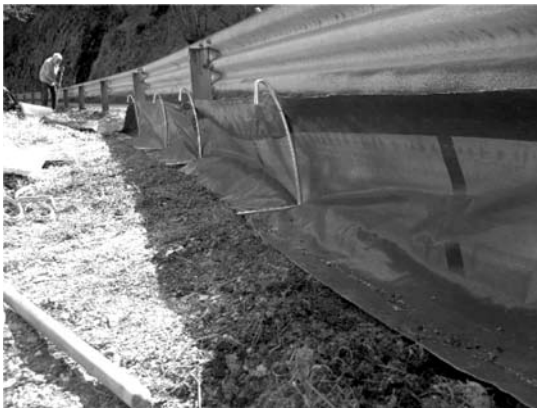
Fig. 1: la posa in opera della barriera antiattraversamento.
