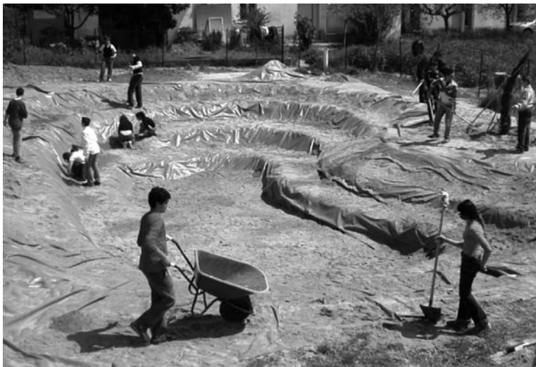
Foto 3: una delle fasi di lavorazione: disposizione del telo e copertura con la sabbia.
